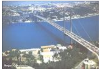
Boğaziçi Köprüsü (İstanbul)
